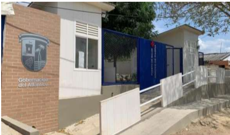
Puesto de Salud de Arroyo de Piedra Después
