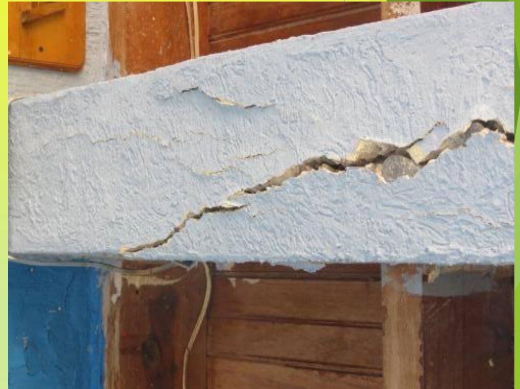
VIGA SALA DE PROFESORES
