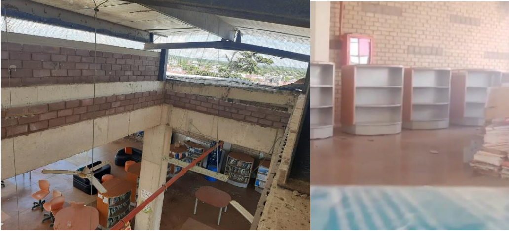
Figura 11: Instalación de mallas y pintura de estantes en la Biblioteca.
