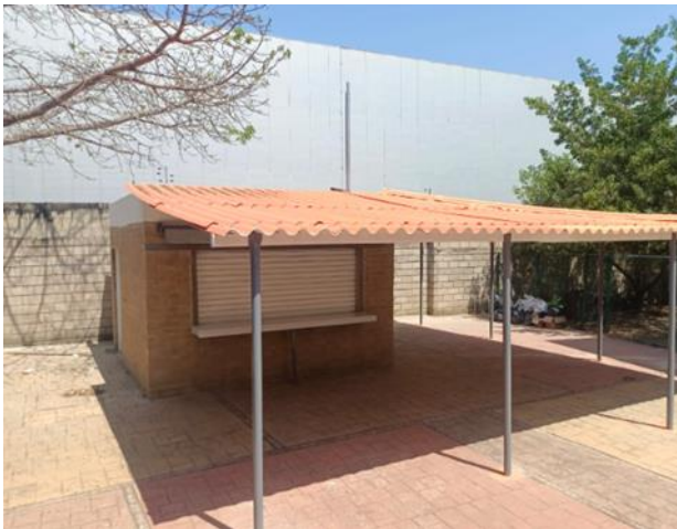
Figura 16: Techo de cafetería
