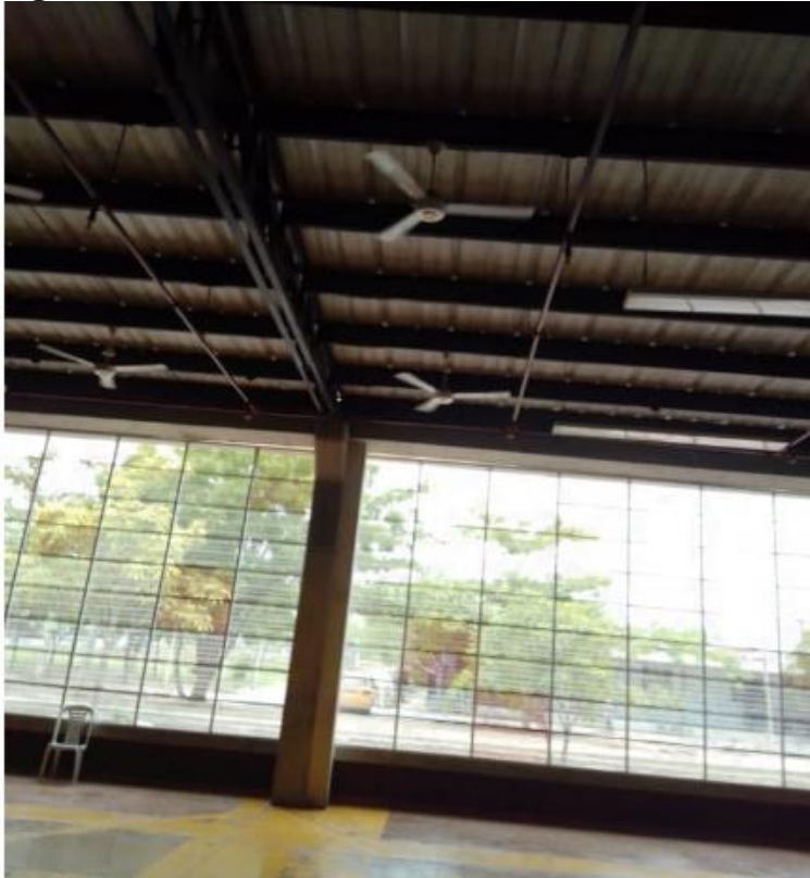
Figura 12: Instalación de abanicos en comedor.
