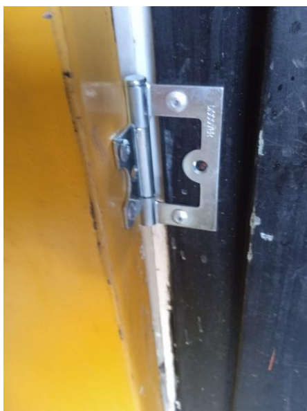
Reparación de puerta y elementos de seguridad.
