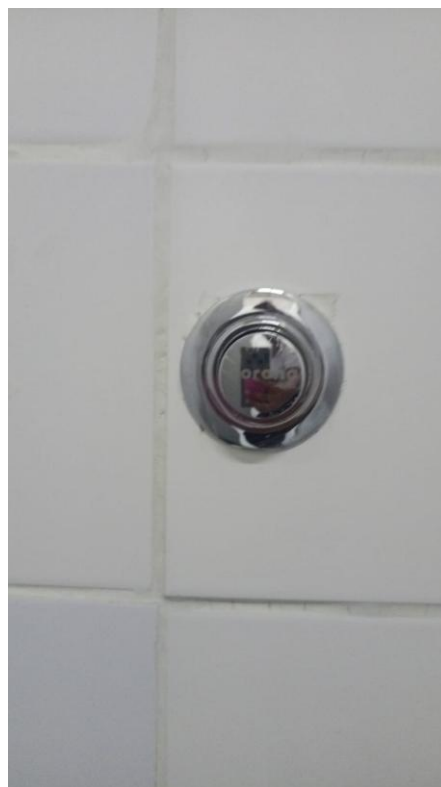
Instalación y mantenimiento de válvula sanitaria.
