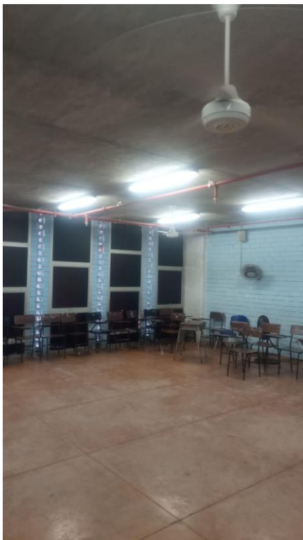
Mejoramiento de iluminación y ventilación en aula.
