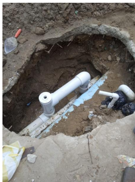
Reparación de redes hidráulicas y sanitarias.
