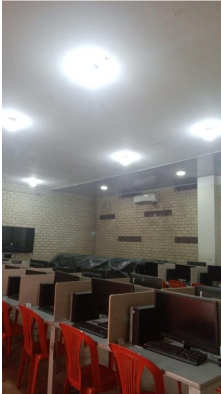
Mejoramiento de iluminación y cielo raso sala de informática 1
