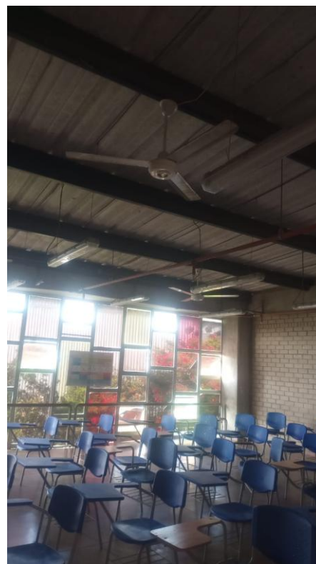
Instalación de nuevos ventiladores..
