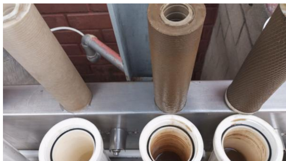
Revisión y cambio de componentes del sistema de filtración.
