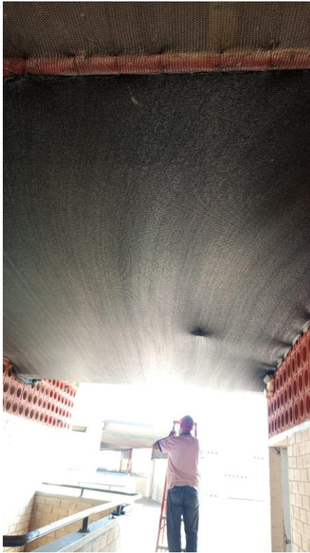
Mantenimiento preventivo en área cubierta.
