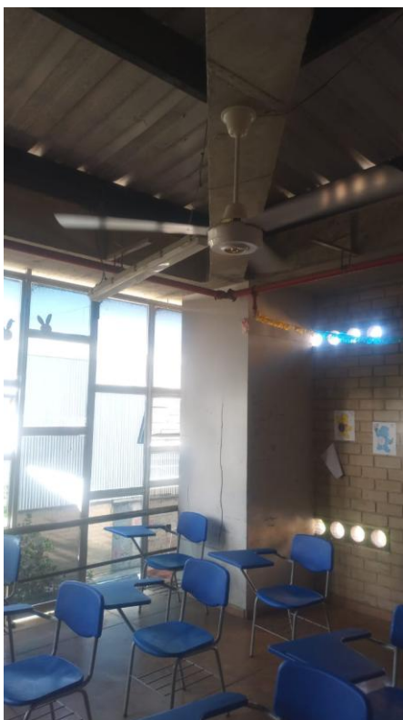
Instalación de nuevos ventiladores.
