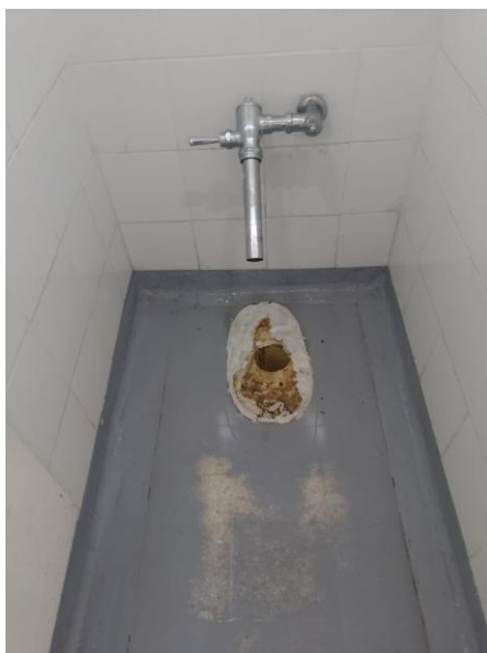
Intervención de sanitario para limpieza y reparación.
