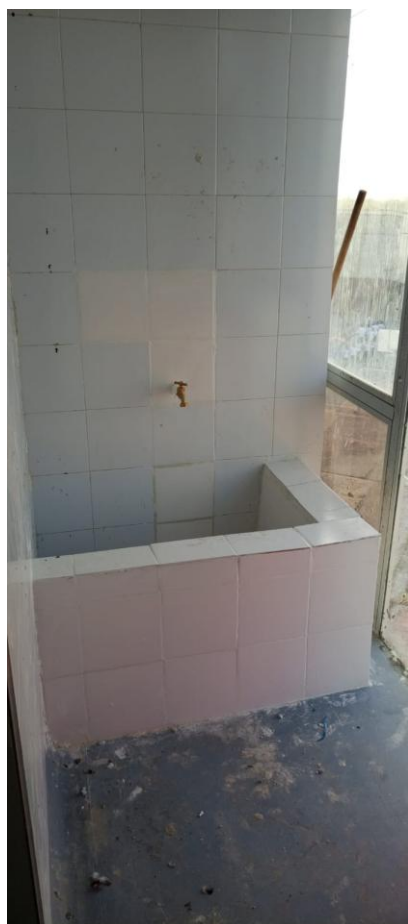
Adecuación de lavatraperos y punto de agua.
