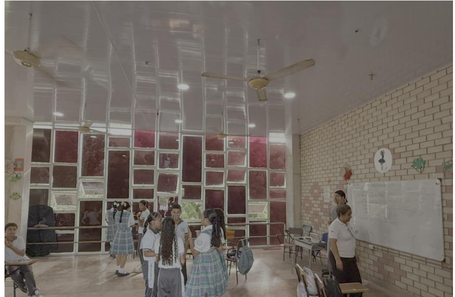
Instalación del cielo raso en salón de danza
