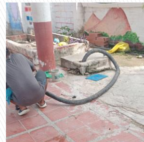
Vaciado de fosa séptica
